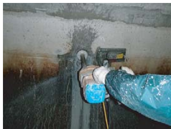
クラック部分のコア抜き状況
