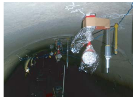
トンネル変状を計測確認しながら作業
