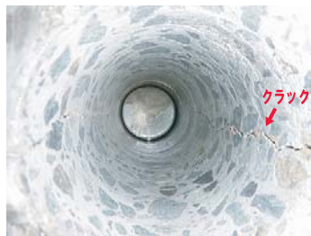
コア抜きされた部分
