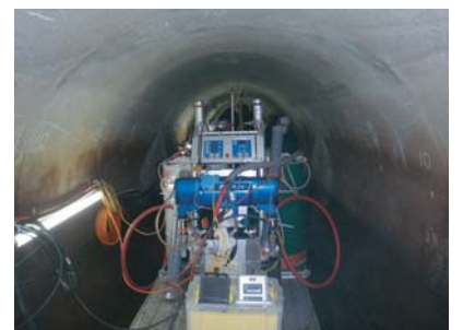
トンネル内での注入装置
